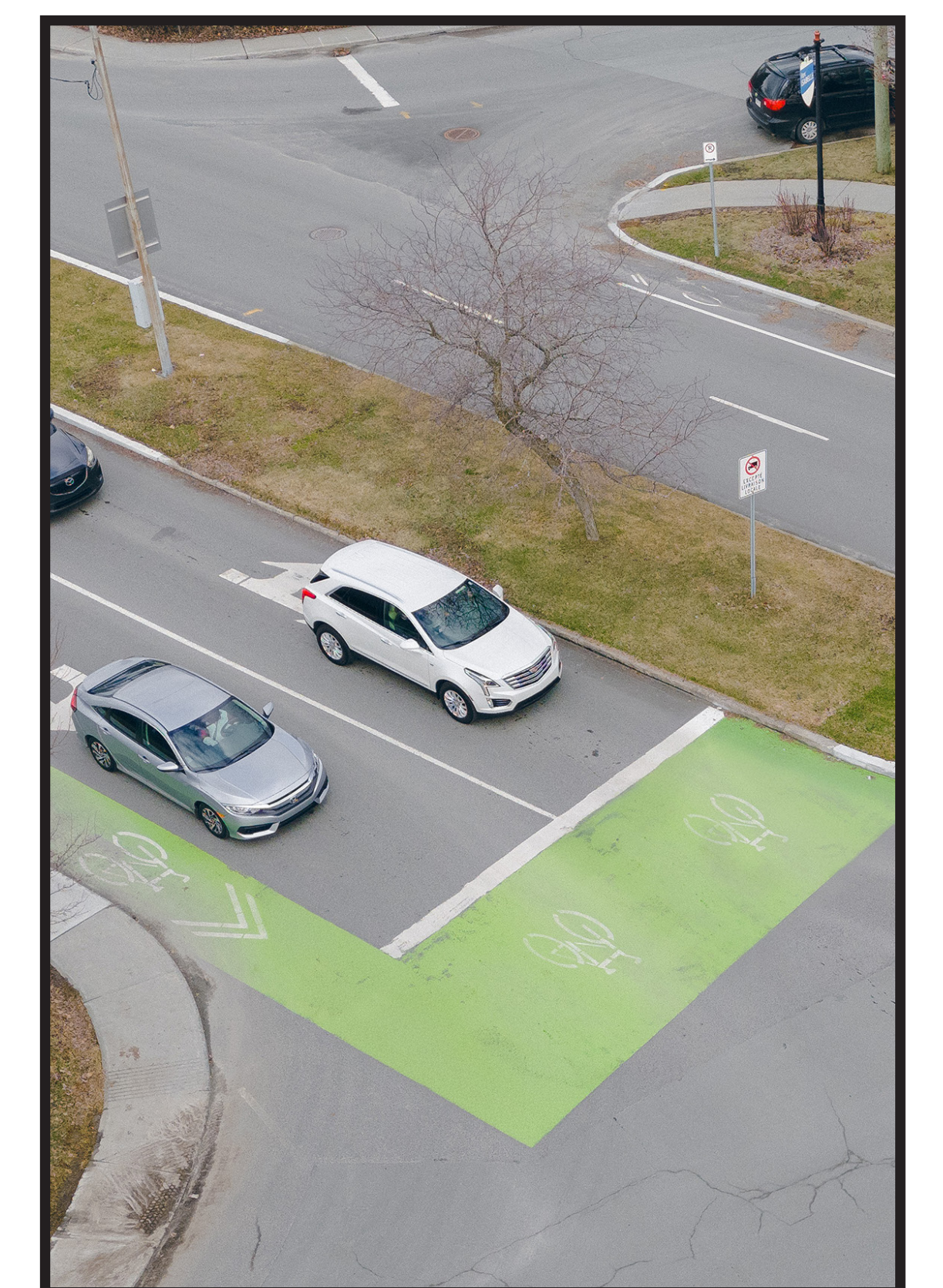
Marquage vert : Le SAS à vélo est une zone devant la ligne d'arrêt des véhicules, où les cyclistes attendent le feu vert.
