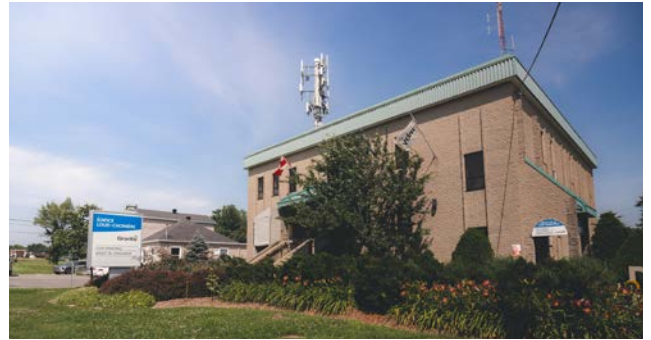
L'édifice Louis-Choinière, situé au 735, rue Dufferin, accueille la cour municipale.
